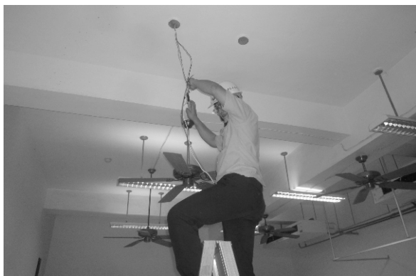
▲營繕組同仁呂學晉檢修衛保組辦公室照明燈
